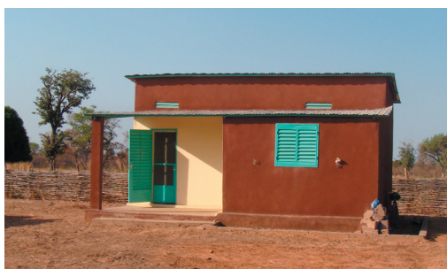
Logement du chef de poste
